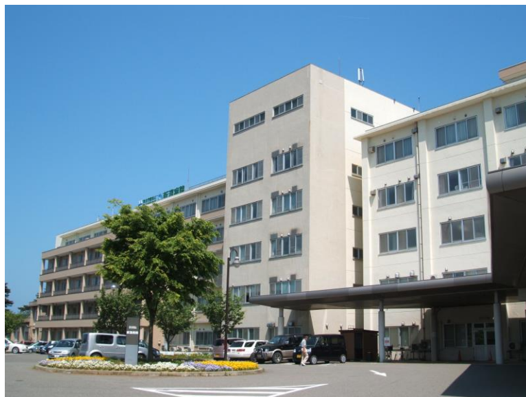
新潟病院正面玄関 外来・病棟
