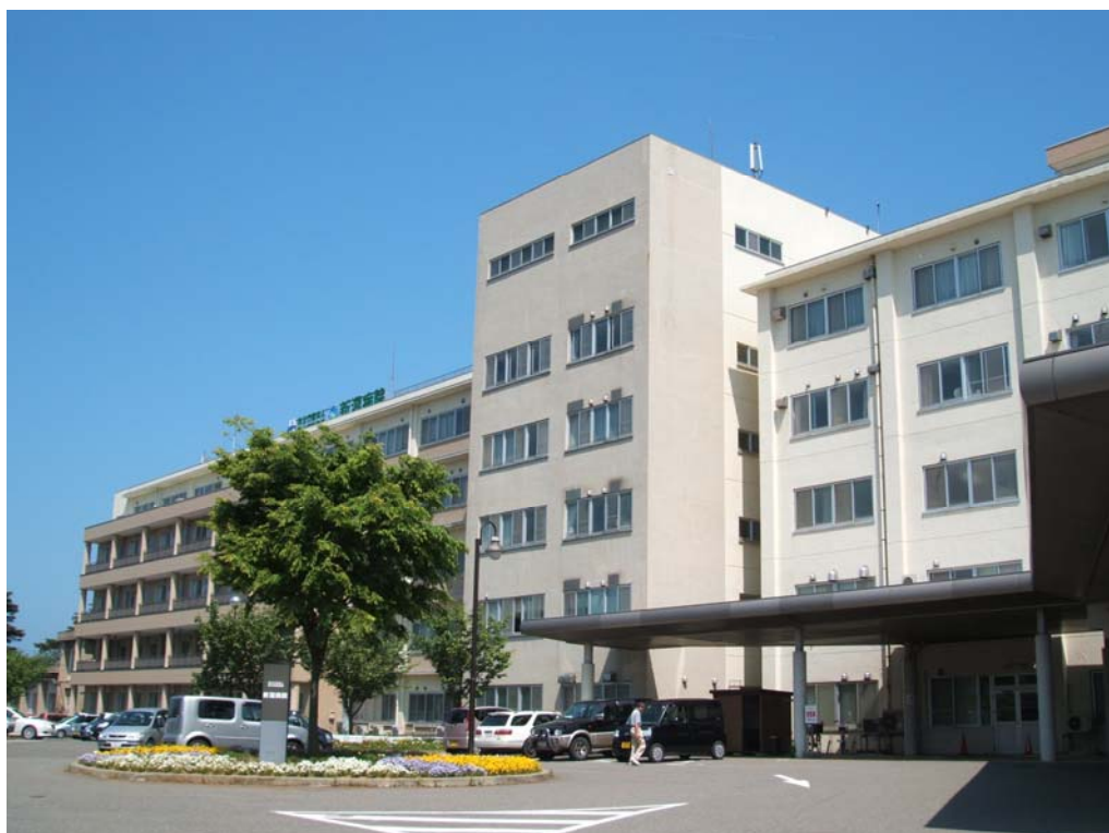
新潟病院正面玄関 外来・病棟
