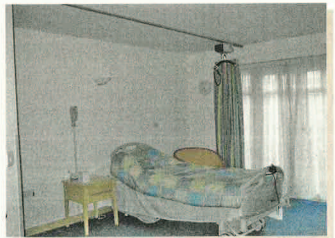
【ホイスト（天井走行リフト）】 全室個室で、天井にホイストが設置されています。 部屋毎に家具やリネンなどが違います。
